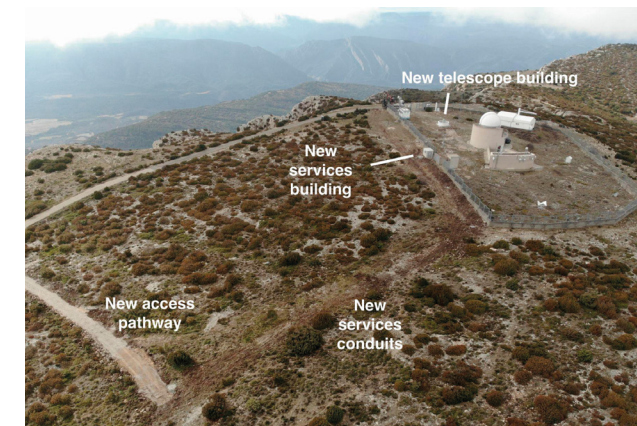
Imatge 2: Vista general de les instal·lacions de l'OdM, incloent la ubicació del nou edifici del telescopi (TRAC) i l'ampliació dels serveis a la nova zona del Teleport de Sant Esteve. Crèdits: IEEC/OdM.
